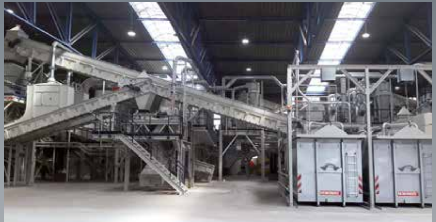
Zakład w Zweibrücken był idealnym miejscem do budowy instalacji recyklingu gipsu
